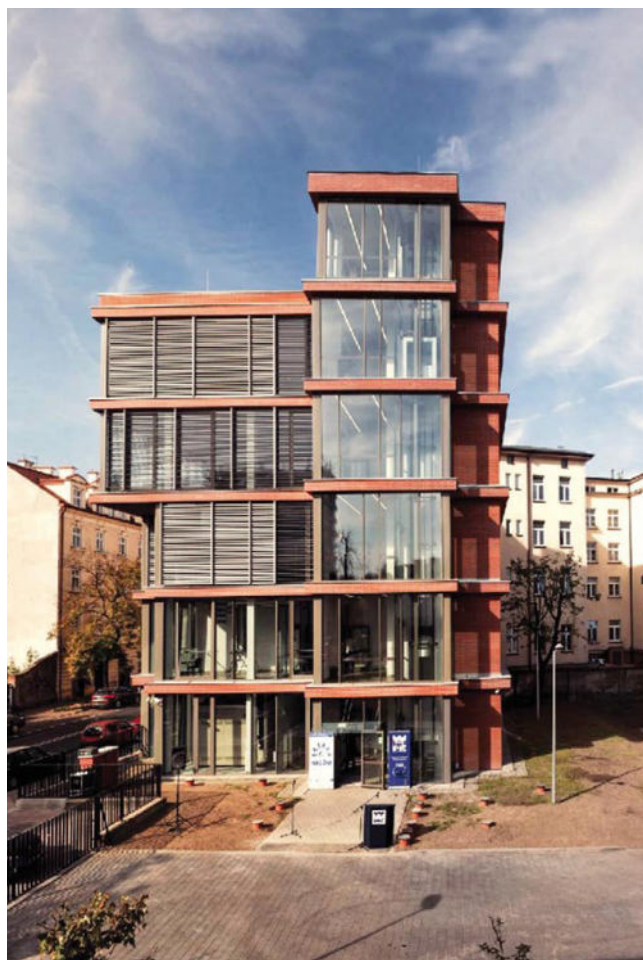
Rys. 1. Małopolskie Centrum Budownictwa Energooszczędnego
