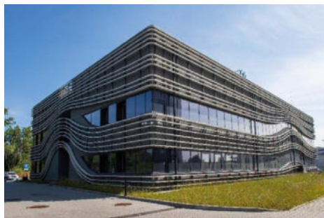
Rys. 1. Widok budynku od strony wjazdu (z lewej) oraz widok wnętrza przestrzeni badawczej tunelu TA1 (z prawej)
