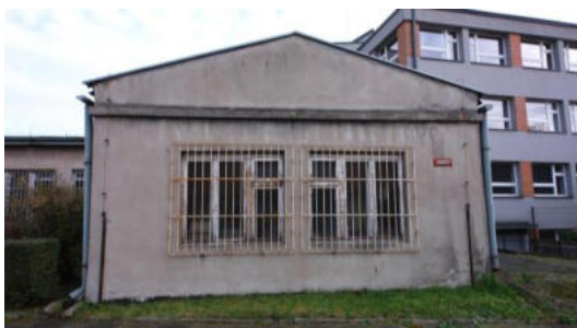
Fot. 3 Budynek przed pracami remontowymi
