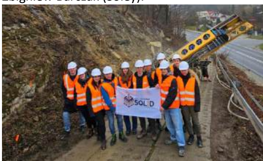
Wzmocnienie skarpy za pomocą gwoździ gruntowych
