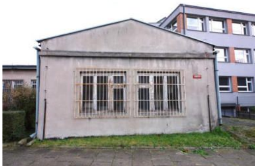
Fot. 1 Budynek 10-14 przed modernizacją.
