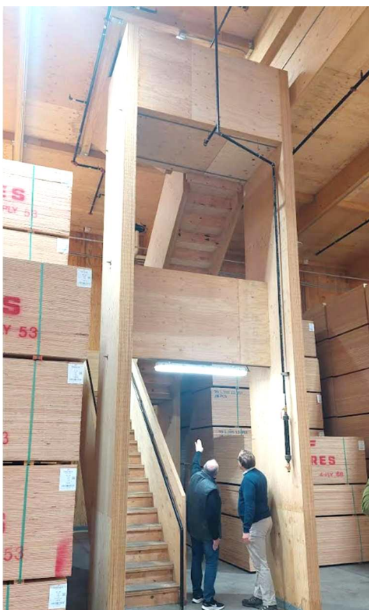
Prefabrykowana klatka schodowa ze sklejki masywnej w drewnianej hali magazynowej firmy Freres.
