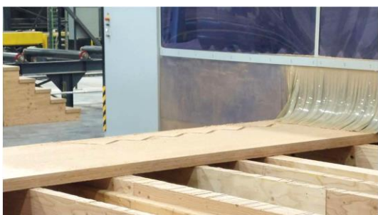
Wycinanie prefabrykowanych schodów ze sklejki masywnej za pomocą maszyny CNC.
