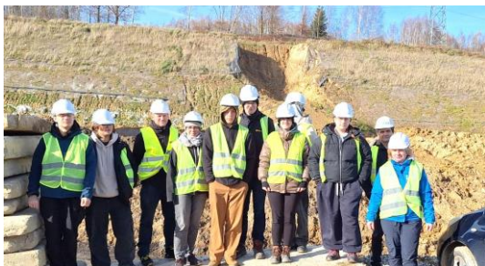
Studenci Koła Naukowego SOLID podczas wizyty na budowie drogi S19 Babica–Jawornik
