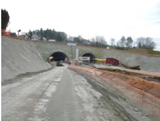
Obie nitki tunelu od strony miejscowości Naprawa. Widoczna wentylacja tunelu
