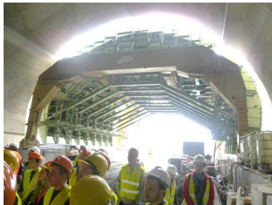
Szalunek ruchomy do obudowy stałej
