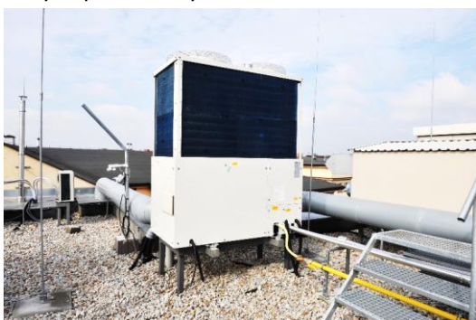
Gazowa pompa ciepła na dachu budynku MLBE
