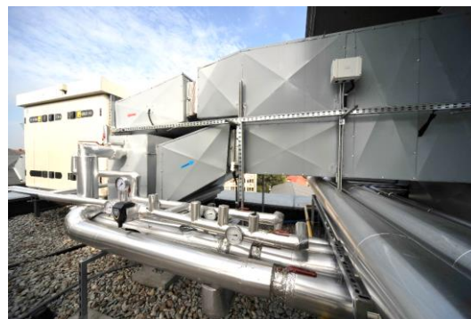
Centrala wentylacyjna zlokalizowana na dachu, obsługująca pomieszczenia III i IV piętra budynku MLBE
