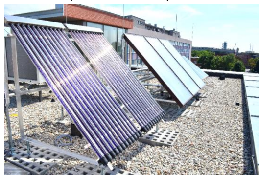
Odnawialne źródła energii na dachu budynku MLBE – kolektory próżniowe oraz płaskie.
